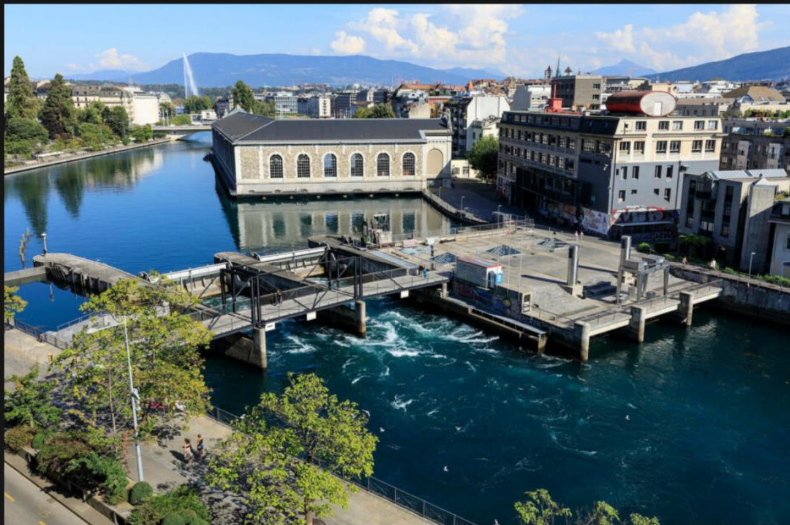
Km 238 / Canton de Genève, Genève, Barrage du Seujet
